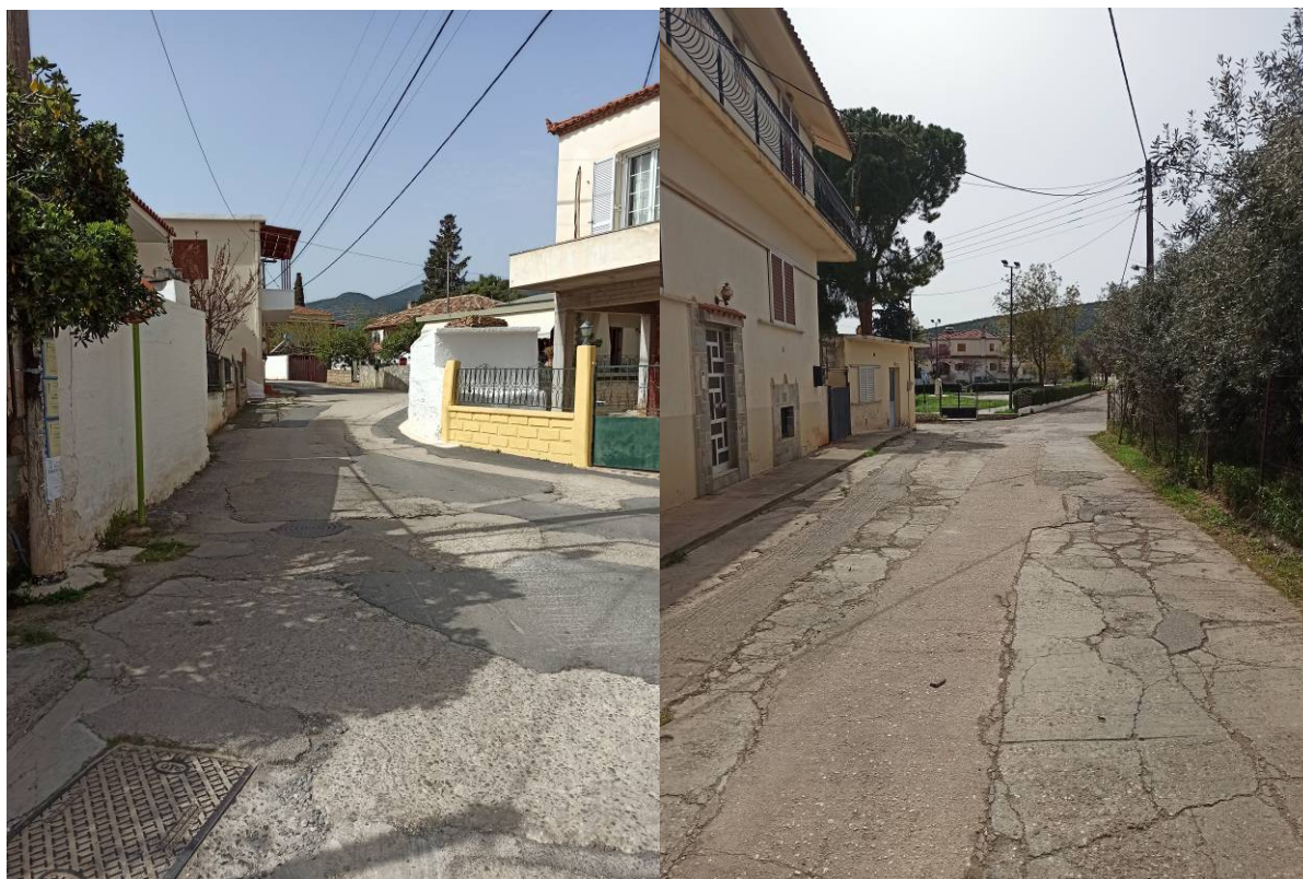
Αρχή Ασφαλτόστρωσης Θέσης Α.1
