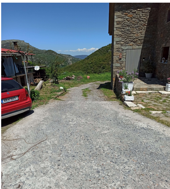
Αρχή Τσιμεντόστρωσης Θέσης 1
